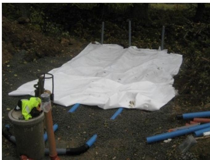
Bild 8 och 9. Ovan visas exempel på en vanlig enskild avloppslösning som inleds med slamavskiljning i tre steg och där den efterföljande reningen består av någon typ av infiltration. Första bilden visar en trekammerbrunn och den andra bilden visar en typ av infiltration.
