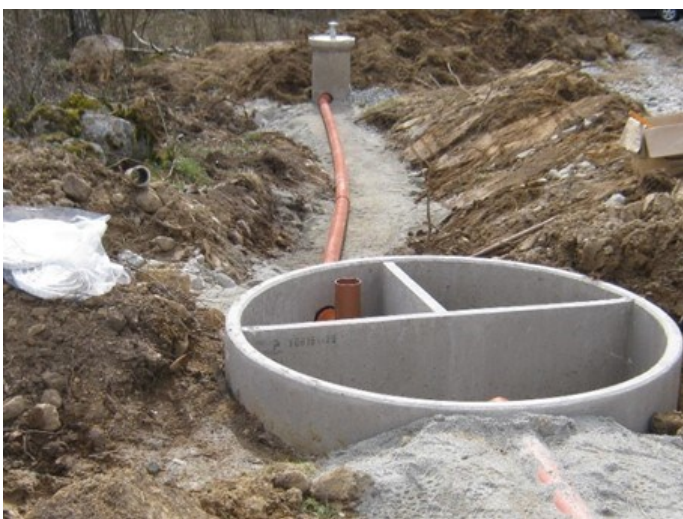
Bild 8 och 9. Ovan visas exempel på en vanlig enskild avloppslösning som inleds med slamavskiljning i tre steg och där den efterföljande reningen består av någon typ av infiltration. Första bilden visar en trekammerbrunn och den andra bilden visar en typ av infiltration.
