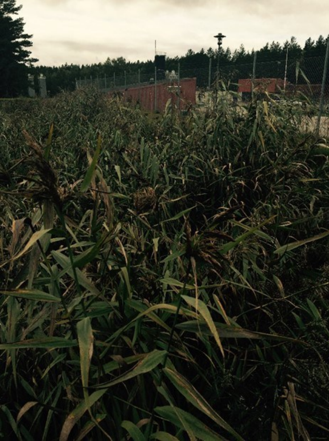
Bild 5 och 6. Slammet som avskiljs från Nybro stads spillvatten hamnar på dessa vassbäddar på Överstatorps reningsverk där det slutligen omvandlas till vassbäddskompost som används som jordförbättringsmedel inom jordbruket
