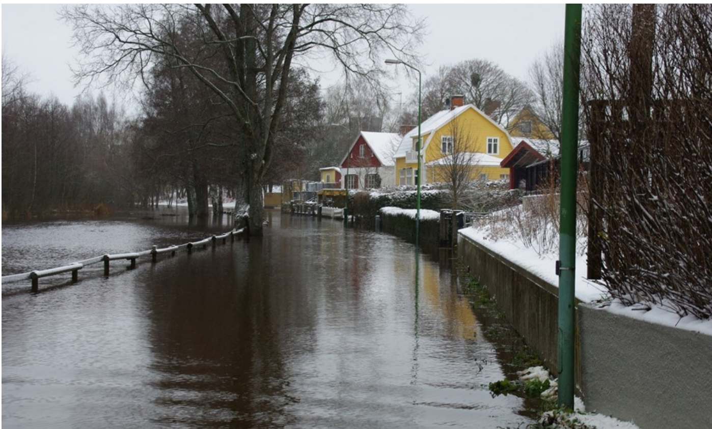
Bild 10. Foto från Strandvägen i Nybro tagen i november 2010. Observationer som gjordes på olika platser i kommunen i samband med det intensiva regnvädret 2010 stämmer väl överens med den översvänningskartering som gjordes 2013.
