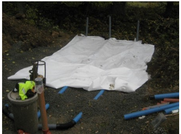
Bild 8 och 9. Ovan visas exempel på en vanlig enskild avloppslösning som inleds med slamavskiljning i tre steg och där den efterföljande reningen består av någon typ av infiltration. Första bilden visar en trekammarbrunn och den andra bilden visar en typ av infiltration.
