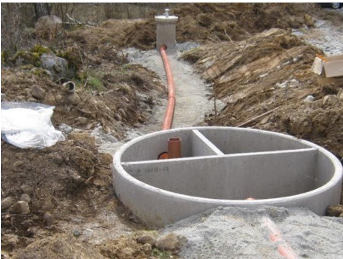
Bild 8 och 9. Ovan visas exempel på en vanlig enskild avloppslösning som inleds med slamavskiljning i tre steg och där den efterföljande reningen består av någon typ av infiltration. Första bilden visar en trekammarbrunn och den andra bilden visar en typ av infiltration.
