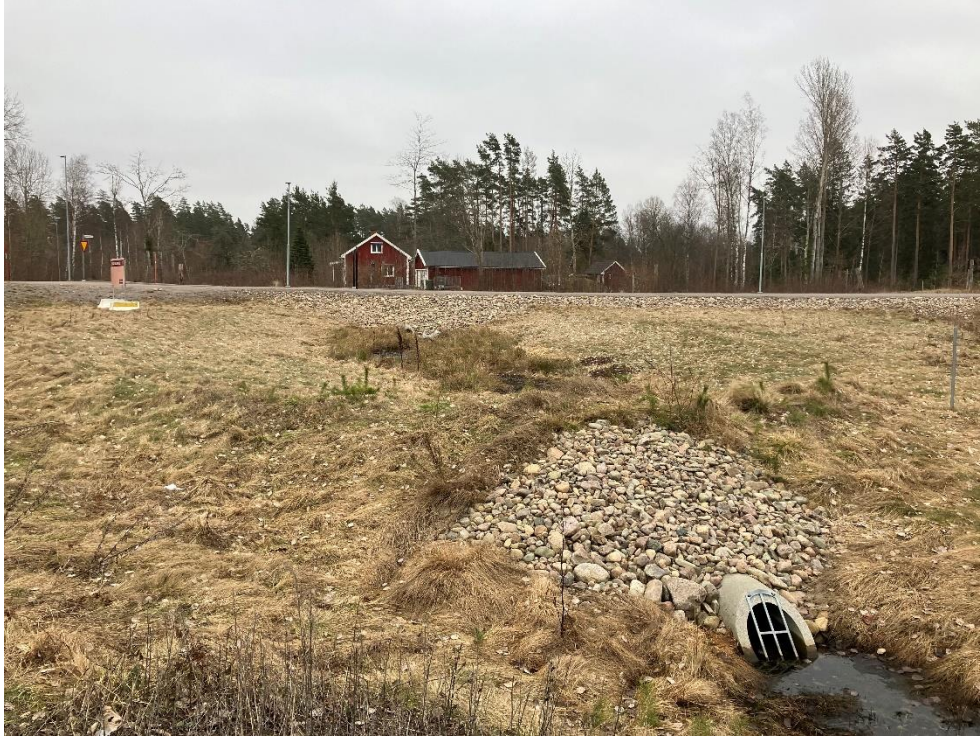
Figur 27. Befintlig dagvattenanläggning vid Braxvägen (ID C i Bilaga 1). Visar inloppet till anläggningen i förhållande till Braxvägen.
