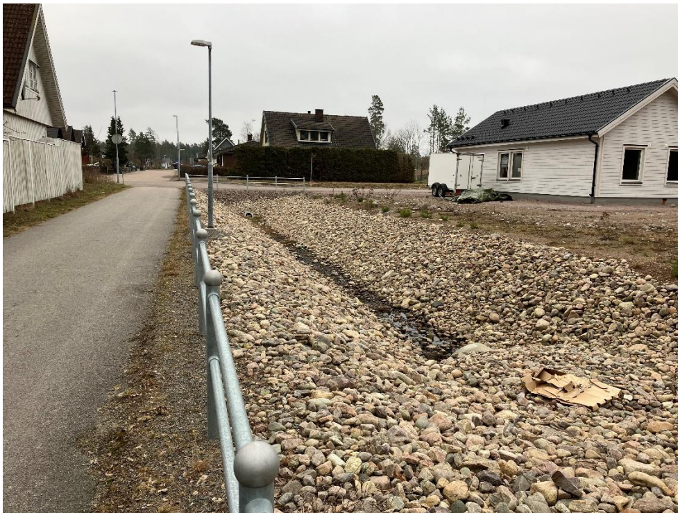
Figur 25. Foto på befintlig fördröjningsanläggning vid Gäddvägen (ID B i Bilaga 1).
